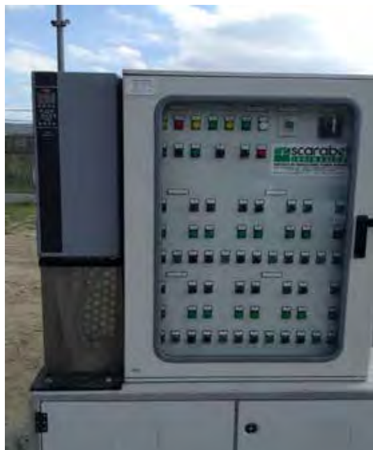
Inverter VLT AQUA Drive FC 202 IP66 installato outdoor in prossimità della vasca di accumulo dell'acqua
