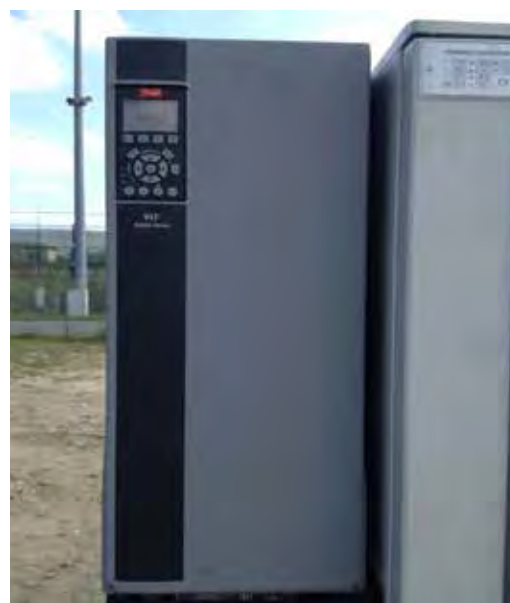
Inverter VLT AQUA Drive FC 202 IP66 installato outdoor in prossimità della vasca di accumulo dell'acqua
